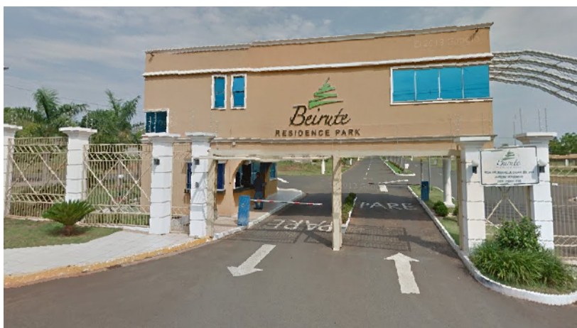
Figura 10: fachada do Condomínio Beirute Residence Park 32
